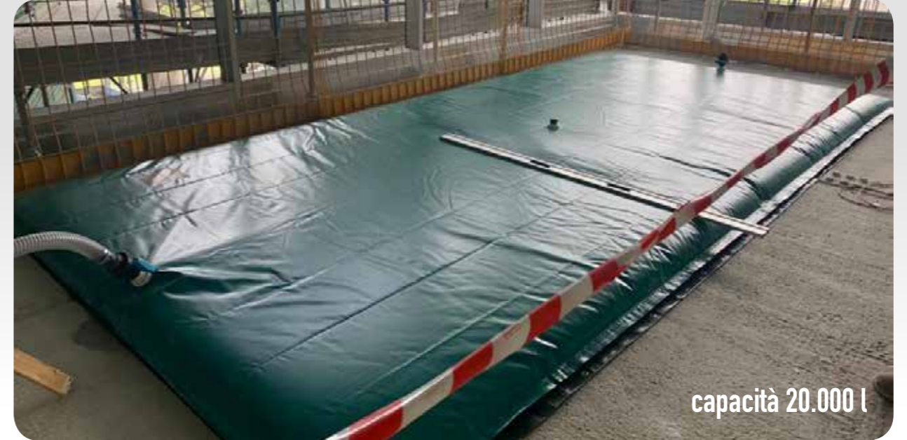
Cisterne di deposito temporaneo per impianti di trattamento delle acque reflue e percolato
